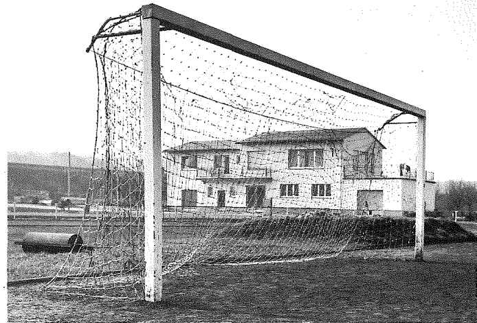
... nach der Fertigstellung 1968
